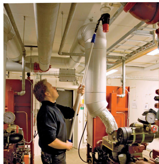
Nedan: NEA:s tekniker utför kvartalsprovning av brandlarmsanläggning.
